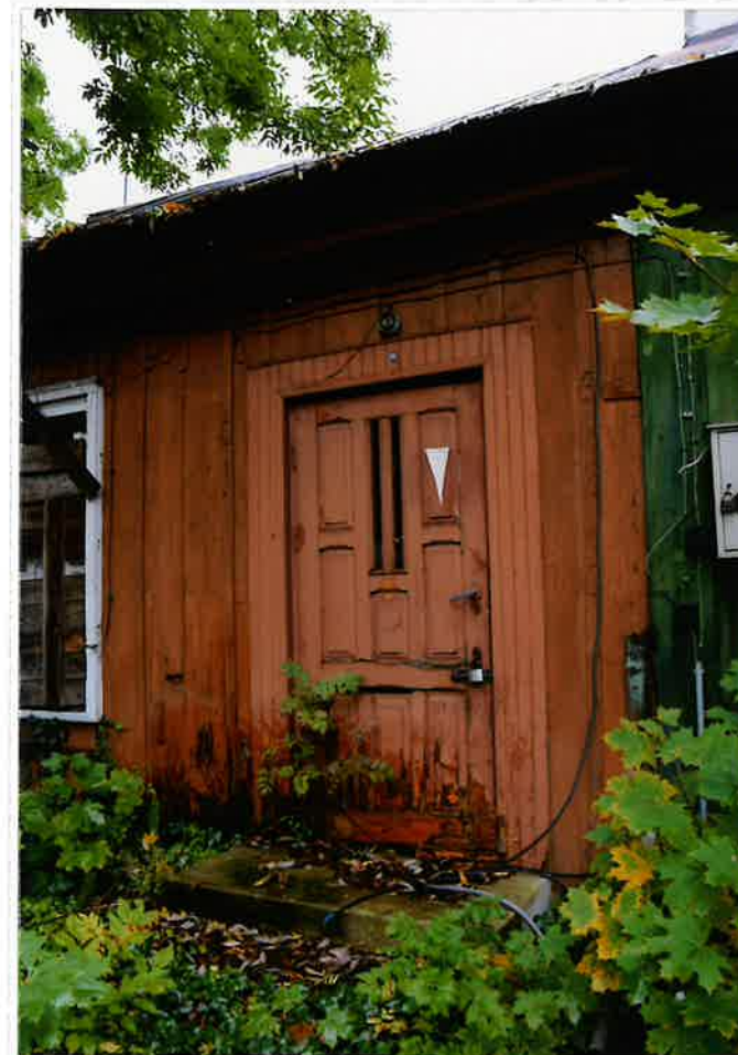
Fot. 5. Elewacja tylna, drzwi.
