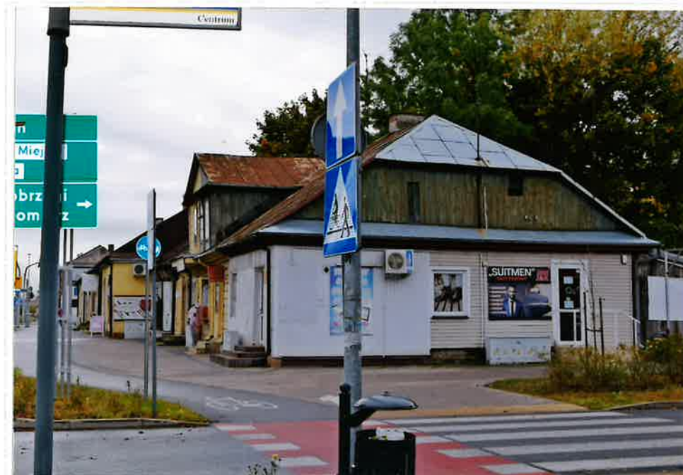
Fot. 2. Elewacja boczna, budynek w zabudowie.
