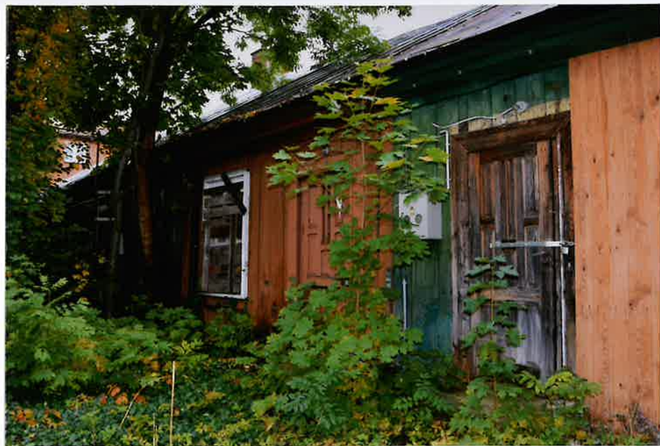
Fot. 6. Elewacja tylna
